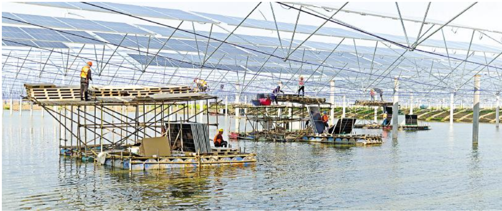
通威“渔光一体”项目抓紧施工
