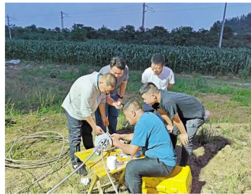
项目工作人员加班加点,保障项目顺利并网
