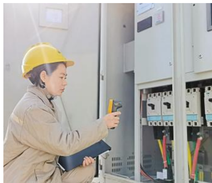
查看运行情况,护航安全生产
