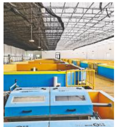
东营项目工厂化循环水养殖车间
